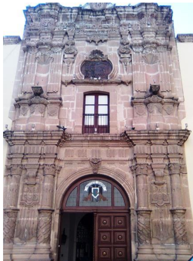
Figura 1: Frontispicio del Edificio Central de la UJED
